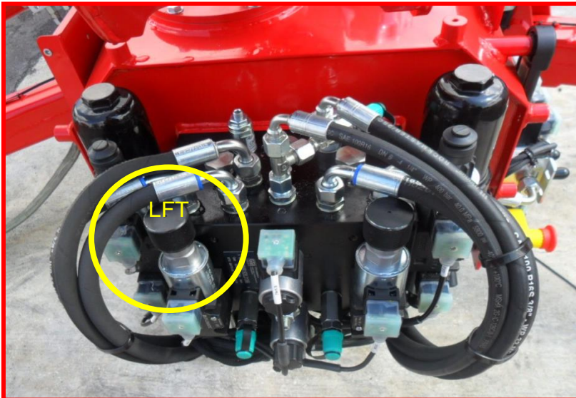
Figure 22 : vanne gauche du banc de filtres.
