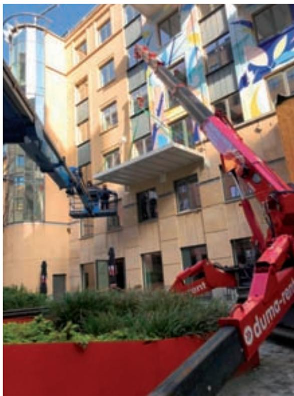
Pour un projet à Bruxelles, plusieurs balcons devaient être installés. Notre commercial s'est rendu sur le chantier pour évaluer les besoins et a proposé notre mini grue avec stabilisateurs UNIC 706-2 et la nacelle télescopique GENIE SX135XC (hauteur de travail 43m). Ces machines ont donc été sélectionnées pour mener à bien cette mission. Afin de bien démarrer le chantier, le client a souhaité engager un de nos opérateurs expérimentés pour une explication experte et le placement de la machine.
