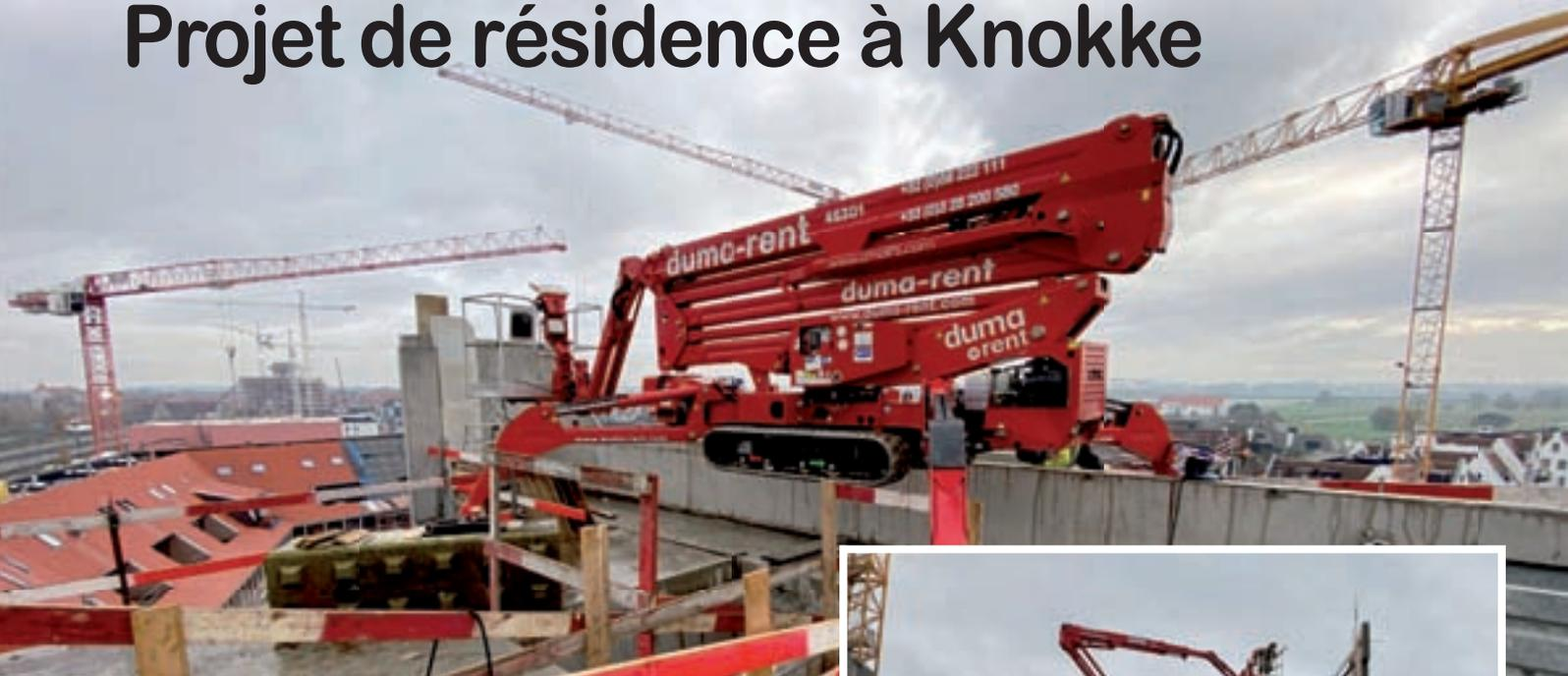
Dans le cadre de la construction d'appartements, un de nos clients cherchait une solution pour hisser 2 nacelles sur un toit à une hauteur de 25 mètres. Une fois positionnées, les nacelles araignées sur chenilles devaient être utilisées pour finaliser la construction du bâtiment. Après une étude approfondie, nos nacelles araignées CMC 523 et 528 ont été choisies.
